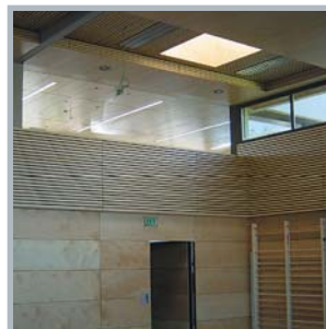
Holz-Akustikdecke. (Turnhalle Lottstetten)
