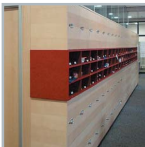
Trennwandsystem mit integrierten Schließfächern und farblich abgesetzten Ablagen. (Brötzinger Schule Pforzheim)
